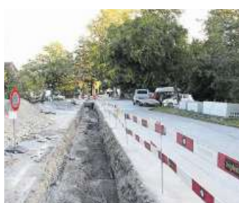
Die Erneuerung der Werkleitungen geschieht parallel zum Ausbau des Tobelbachs. Bild: gb
